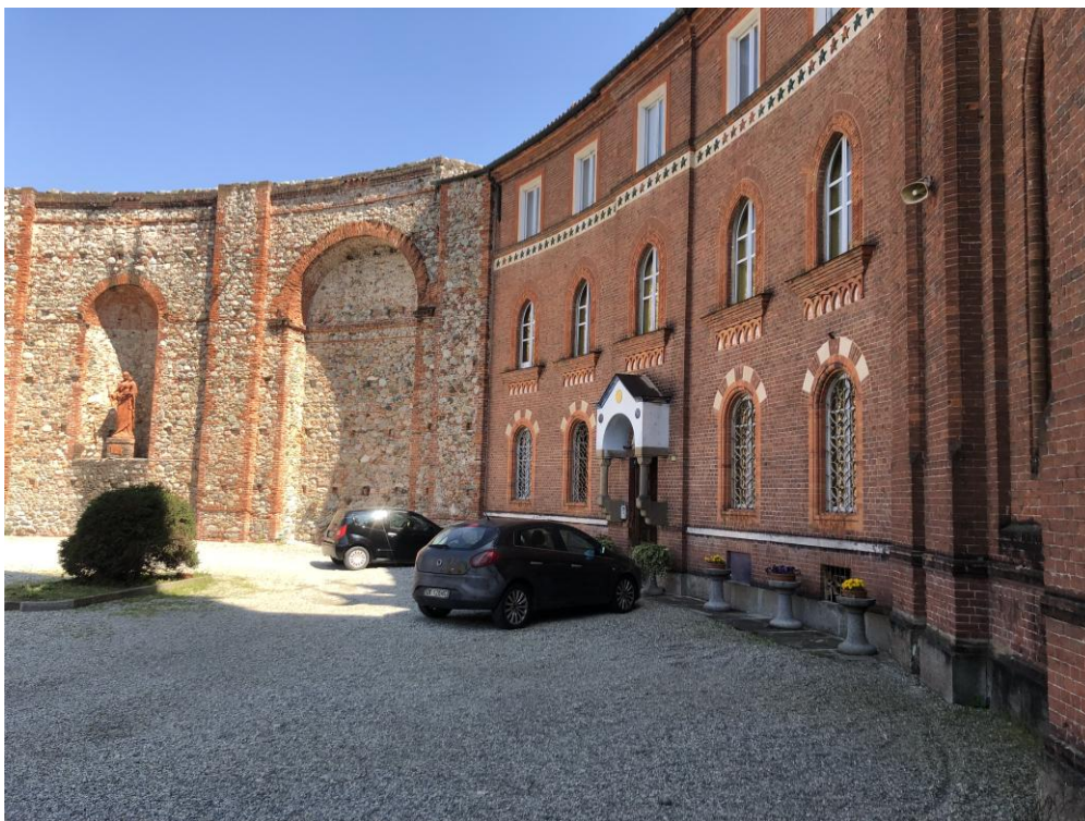
Foto n. 12. Vista da sud verso ovest
