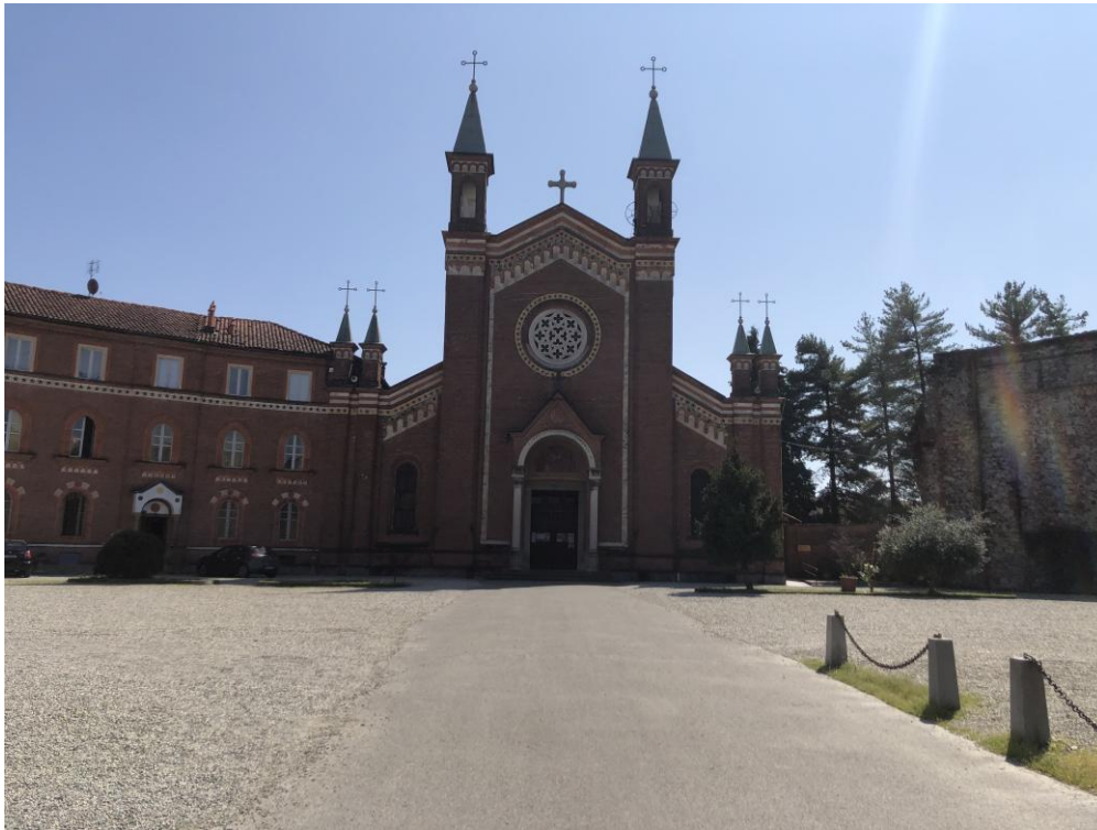
Foto n. 07. Vista da nord verso sud
