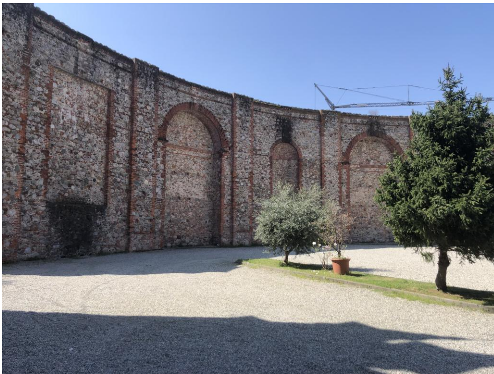
Foto n. 10. Vista da sud verso est
