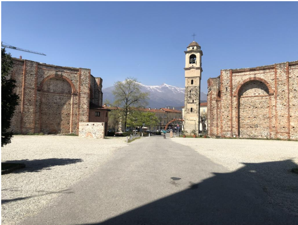
Foto n. 08. Vista da sud verso nord
