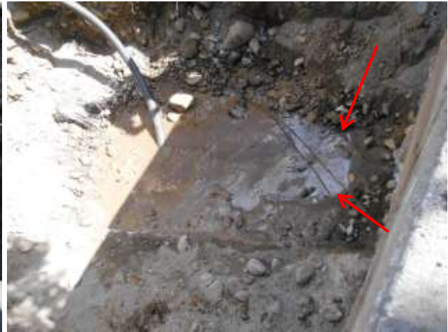
Figura 10: aspirazione dello scavo con autosurgito e indicazione dei punti di ricarica (frecche rosse).
