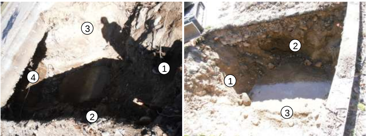
Figura 9: vista dello scavo e identificazione della numerazione delle pareti.
