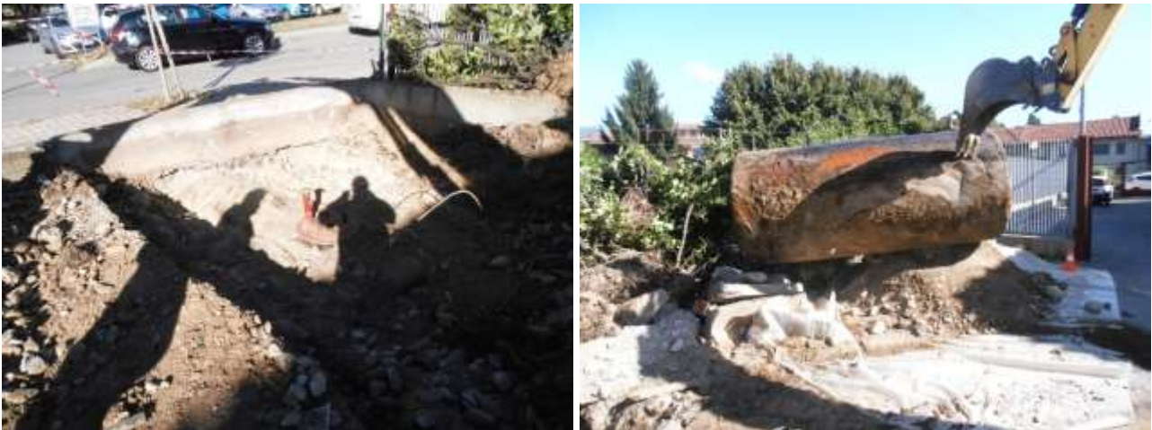
Figura 8: passo d'uomo serbatoio interrato (sinistra) e serbatoio estratto (destra).
