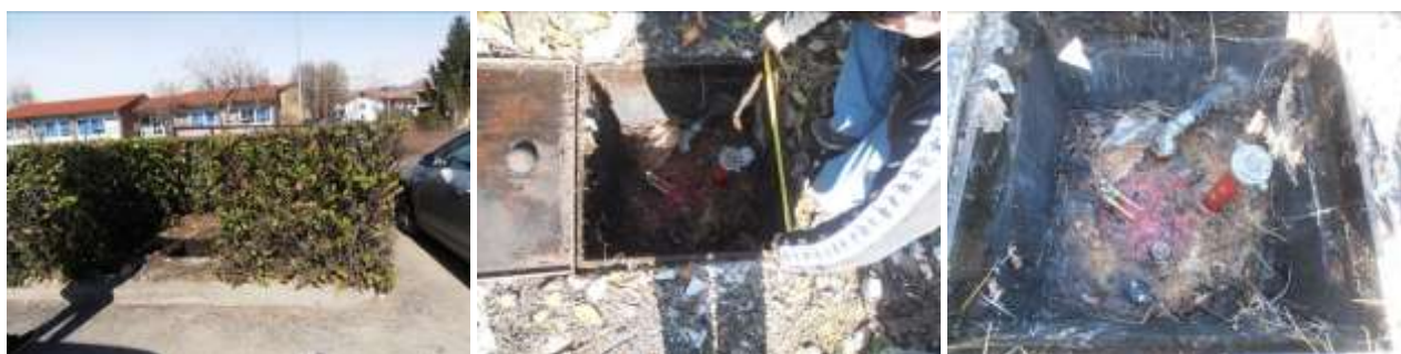
Figura 5 – immagini fotografiche del pozzetto passo d'uomo del serbatoio rimosso.
